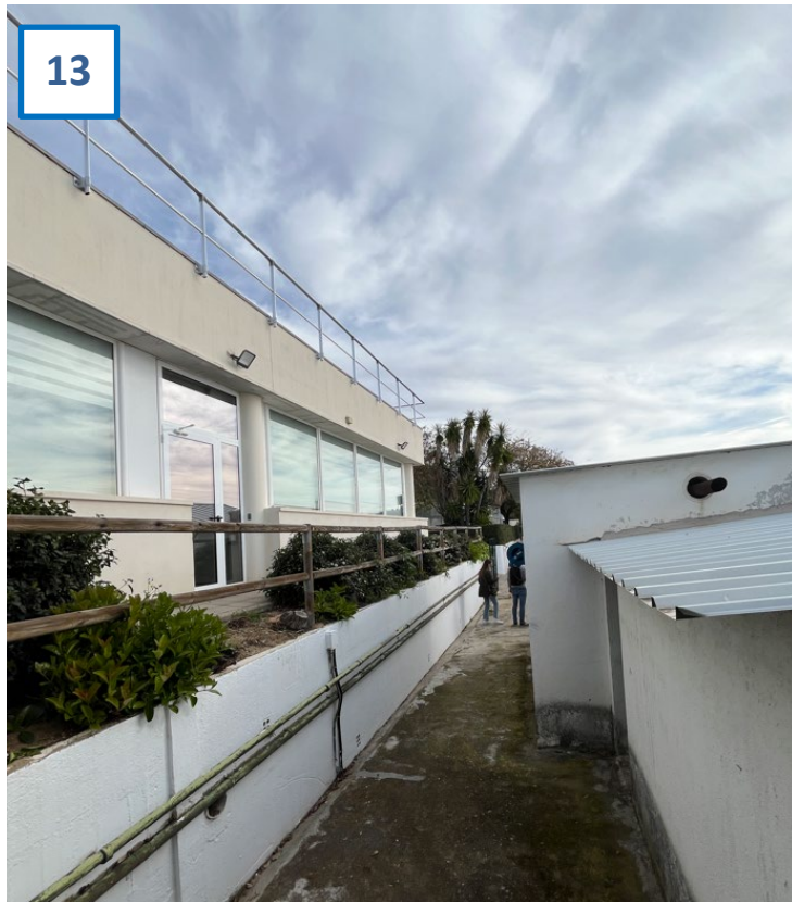
Imatge 13. Pas aeri des de sortida inversor (part dreta foto) fins coberta (part esquerra foto)
