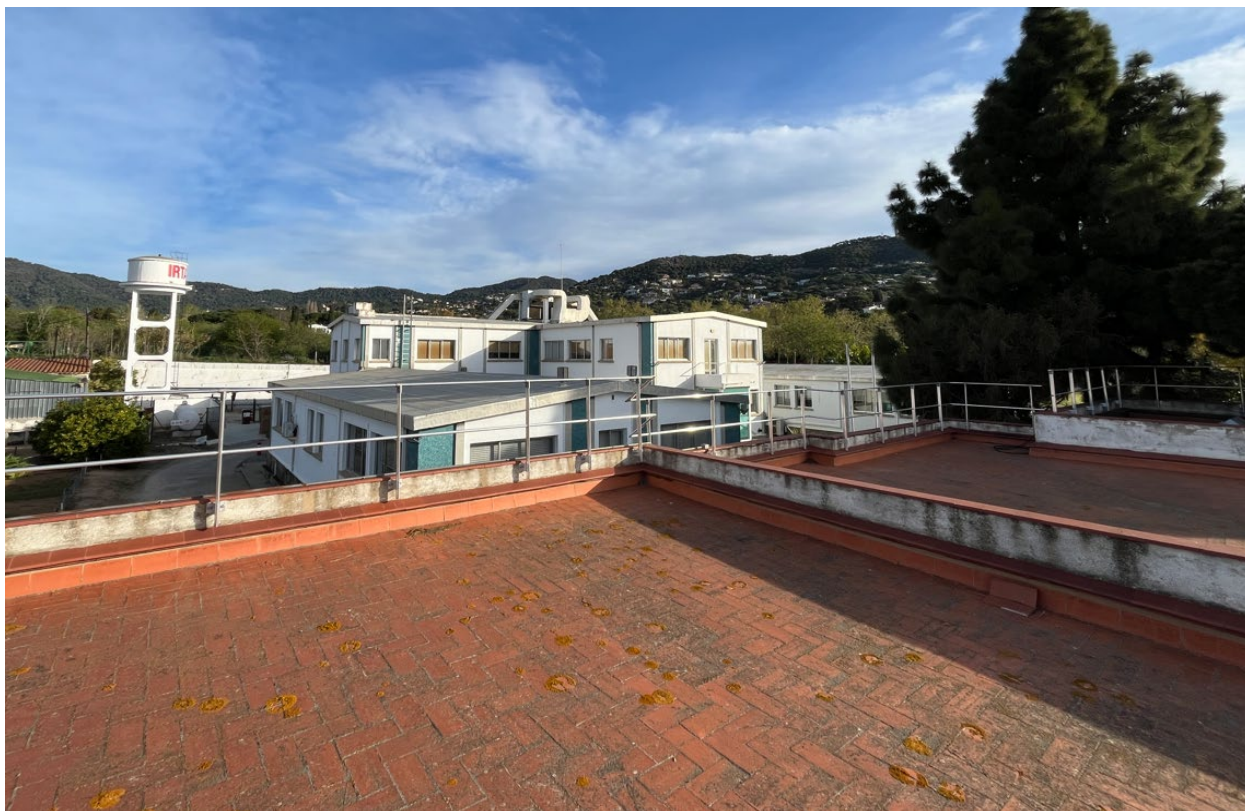
Desnivell peto existent en les cobertes de rajola ceràmica
